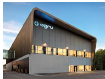
2016: ЗАВОД С ЧИСТЫМИ ПОМЕЩЕНИЯМИ
