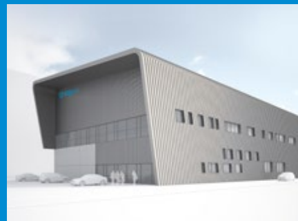
ЗАВОД С ЧИСТЫМИ ПОМЕЩЕНИЯМИ
